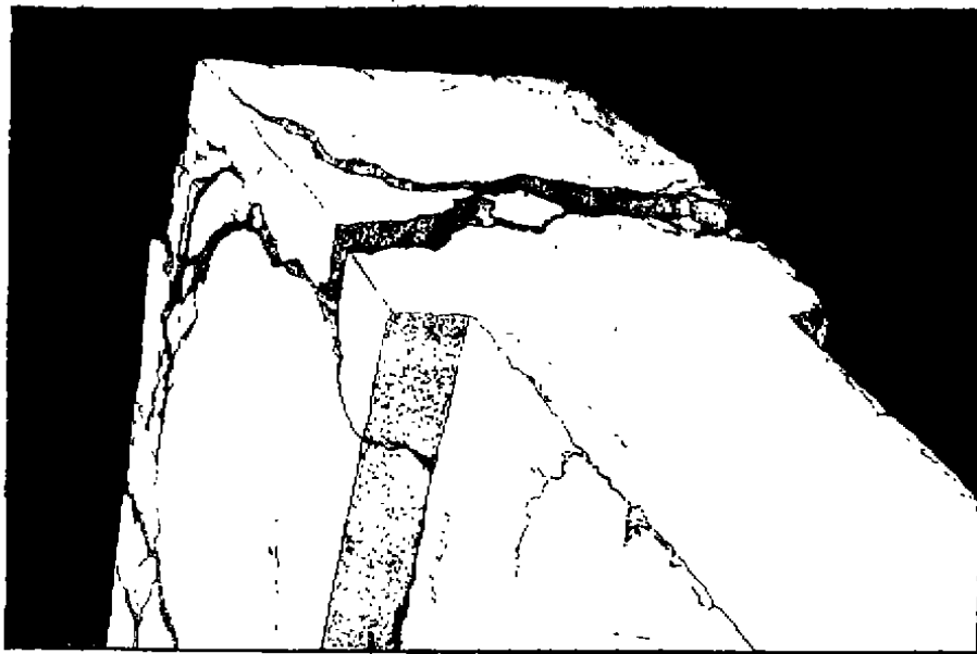
图9 构件UNIT-5破坏后的柱顶部
