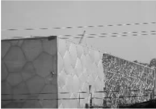
图 20 国家游泳馆(水立方)
