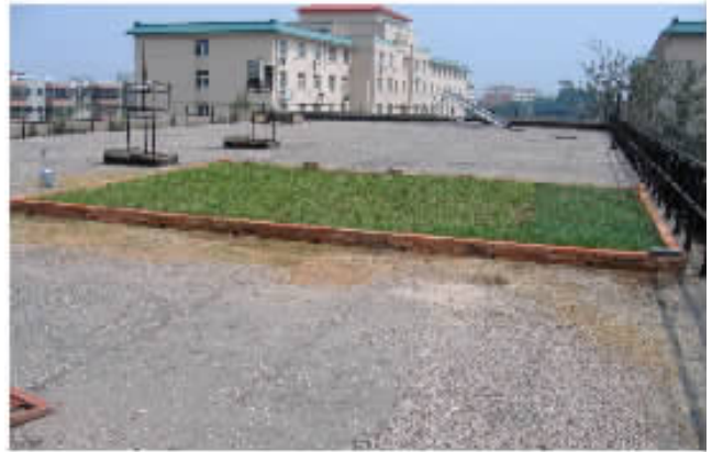
图1 屋顶草坪全景
