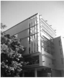
图9 东侧外遮阳板由智能控制系统自动调节角度
