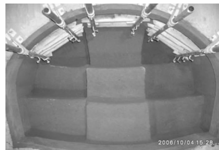
图 7 站厅隧道顺序开挖
