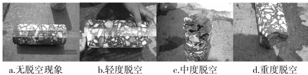
图11 脱空钻芯取样
