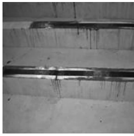
图4 EB-FRP 试件完成图
