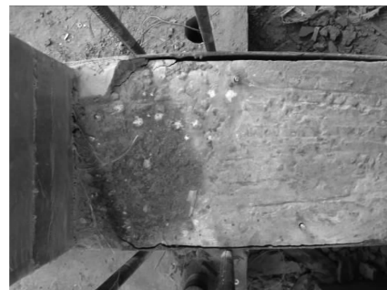
图 10 柱与后浇带连接处③轴附近粘钢的破坏形态
