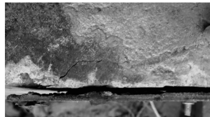
图 9 柱与后浇带连接处①轴附近粘钢的破坏形态
