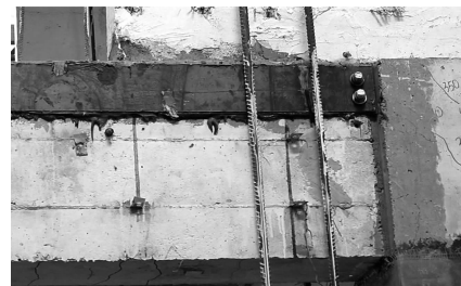
图 11 一层顶框架梁侧粘钢处锚固处理图
