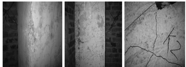
(a)KJ1角部混凝土疏松 (b)KJ1混凝土局部颜色变深 (c)KJ2大量无规则的龟裂裂缝
