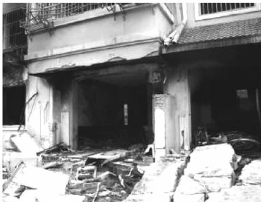
图1 案例1天井围墙倒塌
