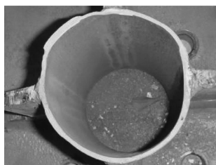
图 10 试件Ⅲ-B 加载至 1/150 时核心钢管断裂图
