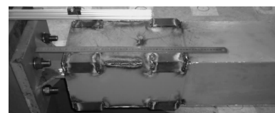
图 8 采用角钢加固后的端部约束钢板
