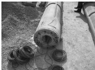
图 5 混凝土应变计导线引出
