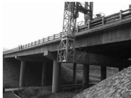
图 5 集锡线某简支梁桥照片
