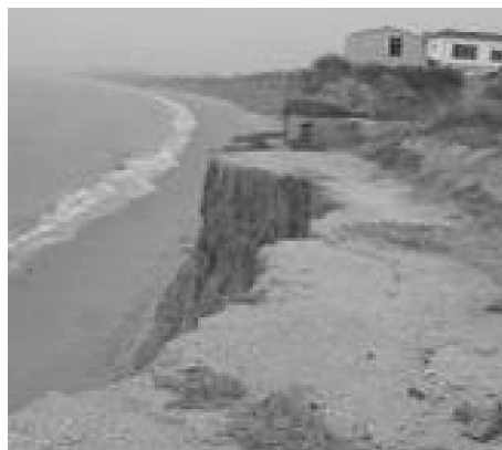
图 4 浪坎坍塌型侵蚀实例
