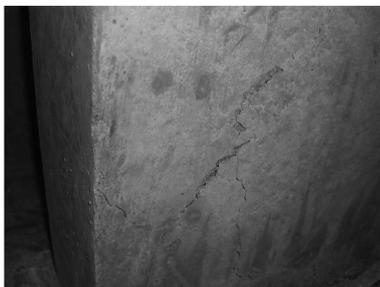
(a)混凝土劈裂破坏
