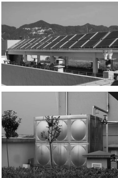
图 3 屋顶太阳能集热器及其恒温水箱
