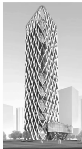
图 1 某超高层建筑实际照片
