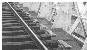
(b)桥面板上安装调频质量阻尼器
