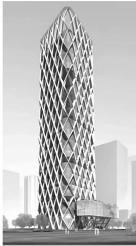
图 1 某超高层建筑实际照片
