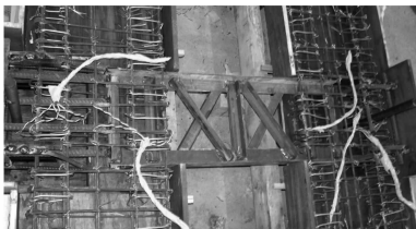
图 2 钢桁架连梁详图
