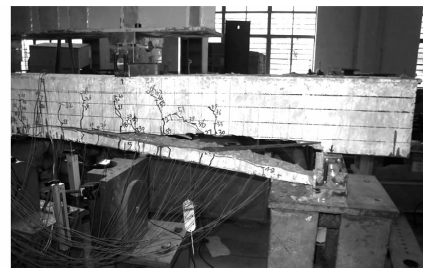
图 13 预设裂缝存在下的典型破坏模式(B-40)
