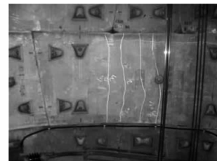
图 3 管片裂缝
