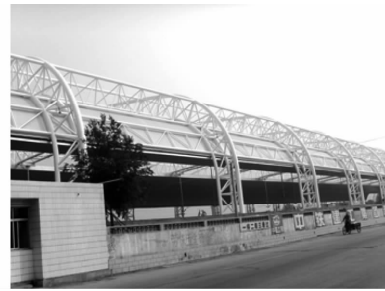
图 5 拱形立体桁架结构站台雨棚
