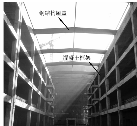
图 2 步行街混凝土框架和钢结构屋盖
