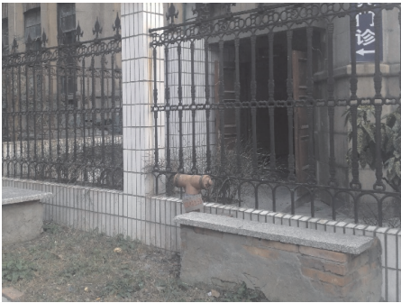
图 6 消防水泵接合器
