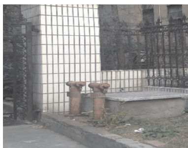
图 19 喷淋水泵接合器
