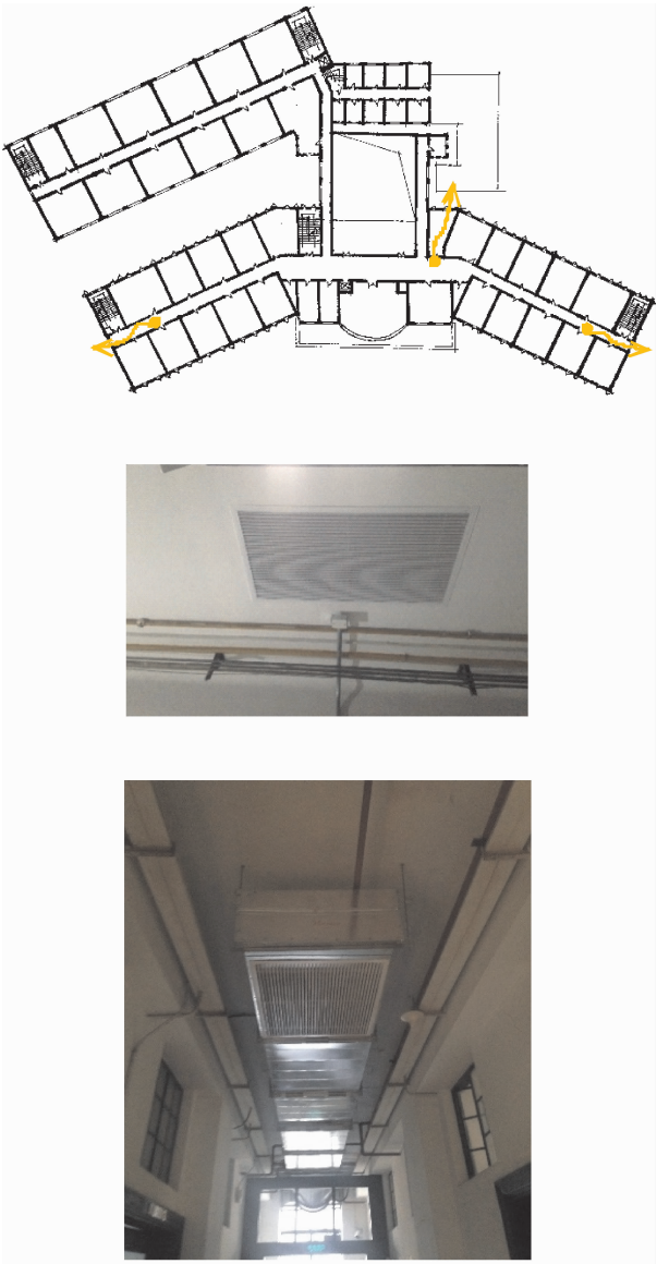
图 25 机械排烟示意图
