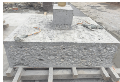
图 2 凿毛并钻孔后承台外观
