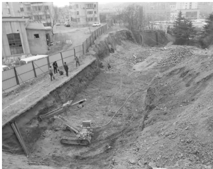
图4 现场钻孔
