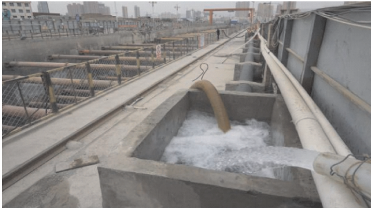
图4 车站深基坑降水过程
