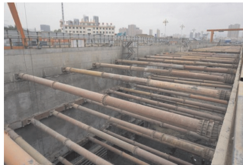
图 1 车站深基坑开挖后现场照片
