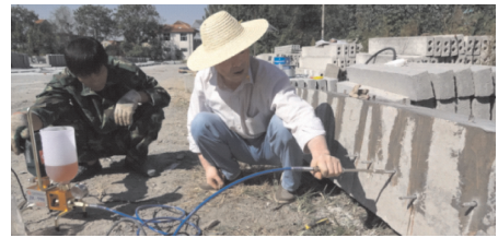
图 8 破坏试验梁的修复及压力灌浆
