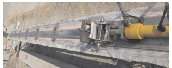
图 7 HB-PRECFRP 加固的试验梁
