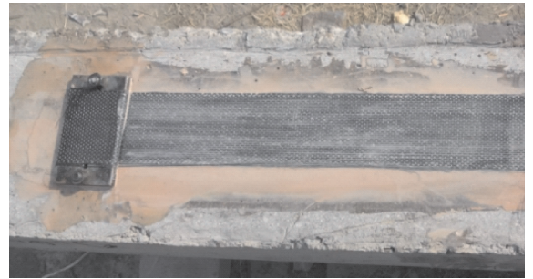
图 5 CFRP 钢板端部锚固
