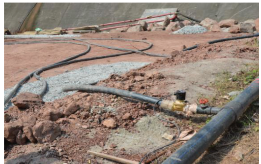
图 9 自动控制阀门安装示意图
