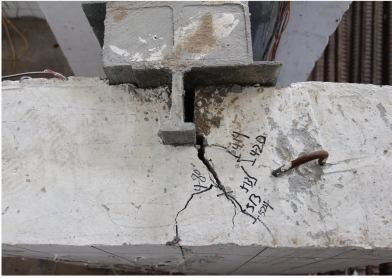
(b) 混凝土块顶面45°角斜裂缝分布
