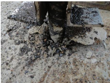
图 7 钢筋抗浮锚杆滑移破坏
