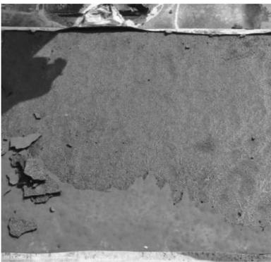
图 2 砂浆揭板检查起皮
