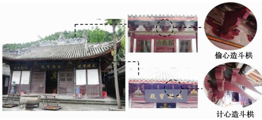
图 3 饶益寺大佛殿前后檐斗拱布置及细部构造
