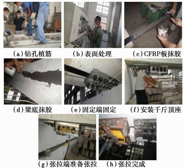
图 2 预应力施加流程
