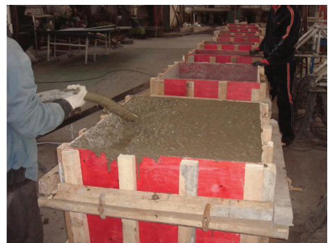
图1 混凝土基体制作
