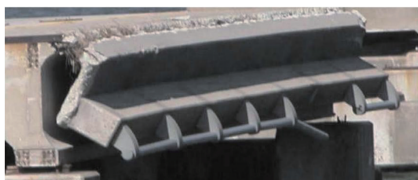
图3 护栏结构破坏形式 [8]
