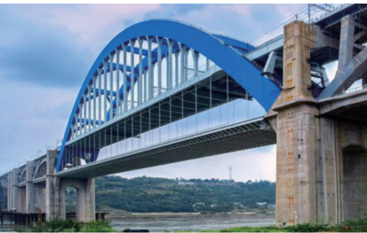
图 15 钢桥面钢箱拱公铁两用桥
