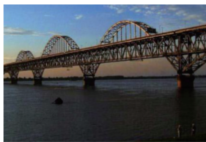
图 13 钢桁梁柔性拱公铁两用桥
