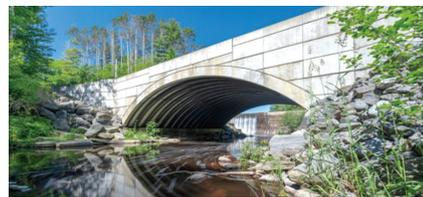
图 17 FRP 主拱的拱桥<sup>[29]</sup>
