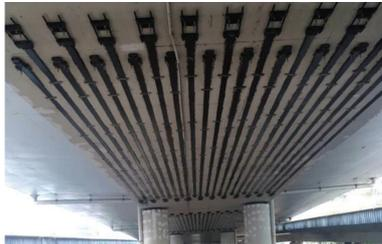
图 13 预应力 CFRP 板加固技术
