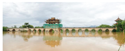
图 7 云南建水双龙桥
