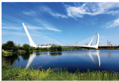
图 13 北京永定河大桥
