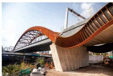
图2 英国新铁路线上的拱桥
