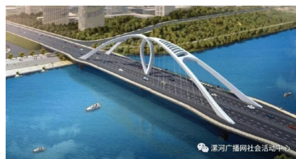
图8 漯河市沙河大桥
