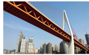
(a) 钢桁斜拉桥
