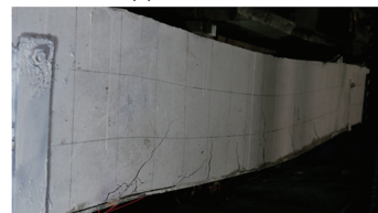
(d) S35(2)-6-B2 中部裂缝剥离破坏
