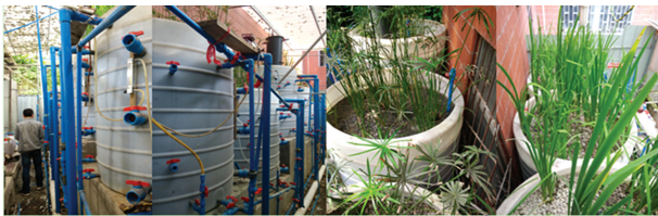
图 2 微曝气人工湿地系统实物图
