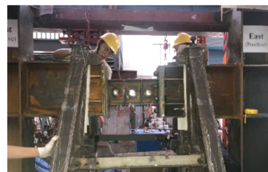
图 9 更换耗能梁段
