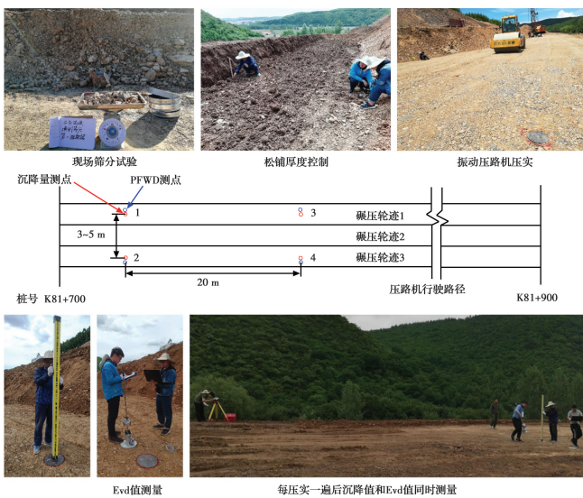
图 2 土石路堤试验段施工工艺
