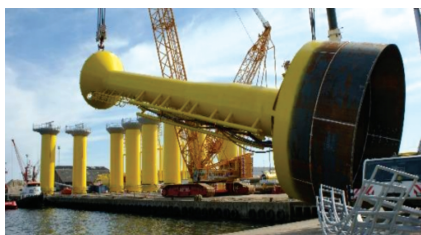
图1 桶形基础(丹麦 Horns Rev 2 项目)
