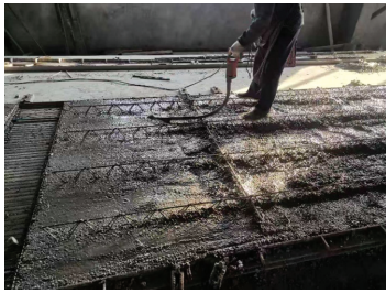
图9 工程应用照片
