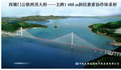
图 2 西埃门公铁两用大桥 (效果图, 中铁大桥勘测设计院集团有限公司提供)
