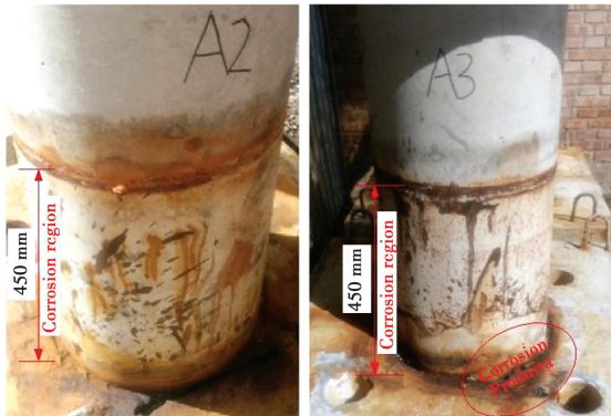
图 6 氯离子侵蚀钢筋混凝土桥柱试件 [22]
